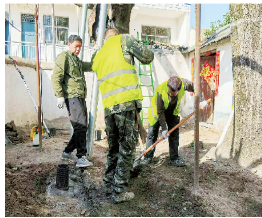
工作人员对古树进行加固作业。
